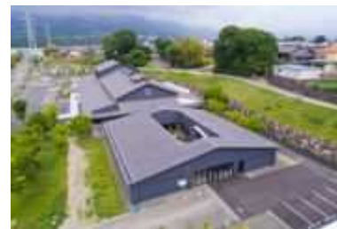
温泉施設（太陽光発電設備設置予定）
